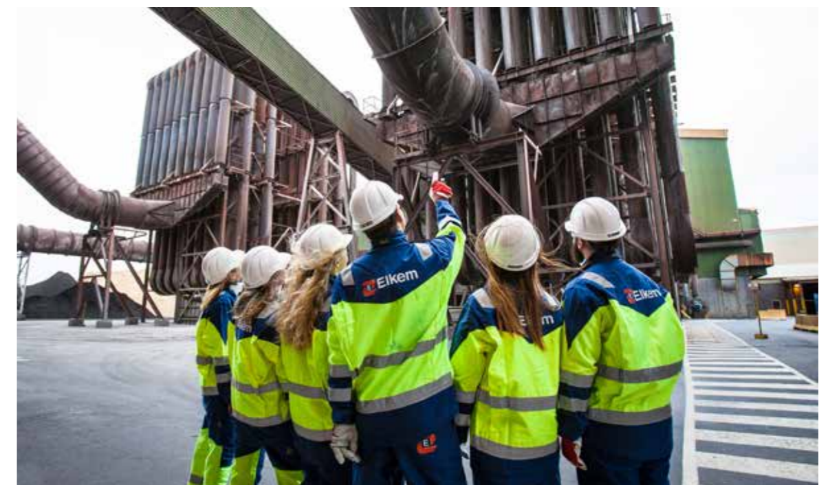
Reykhreinsivirki Elkem Ísland. Árlega fanga virkin um 20.000 tonn af kísilyki sem notað er sem íblöndunarefni í sement.
